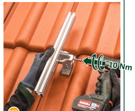
12b Die Klemmkombination mittels Schraube (10 Nm \pm 0,5 Nm) festziehen - fertig!
