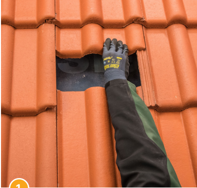
1 Den Dachziegel hochschieben.
