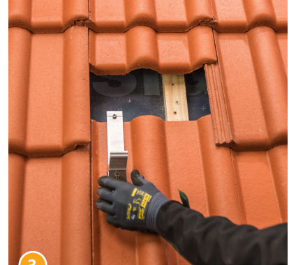
3 ...und Dachziegel einhängen.
