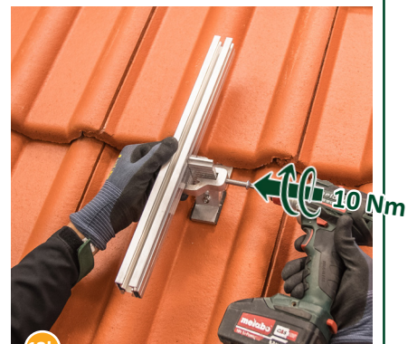
13b Die Klemmkombination mittels Schraube (10 Nm \pm 0,5 Nm) festziehen - fertig!
