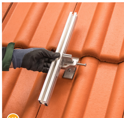
11b Die RAIL ausrichten und einhängen.
