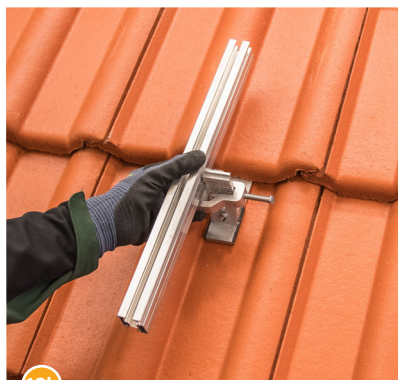
12b Die RAIL ausrichten und einhängen.
