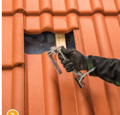
2 Den Haken unterhalb von Dachlatte...
