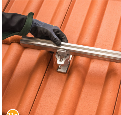
11a Die RAIL ausrichten und einhängen.
