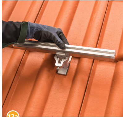
12a Die RAIL ausrichten und einhängen.
