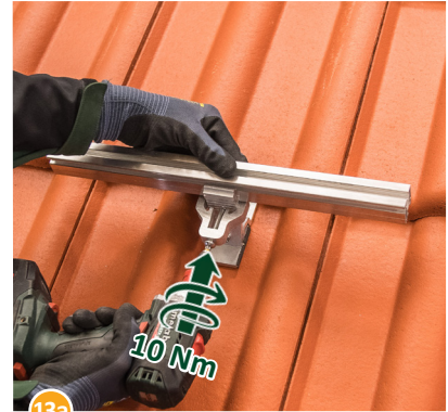
13a Die Klemmkombination mittels Schraube (10 Nm \pm 0,5 Nm) festziehen - fertig!
